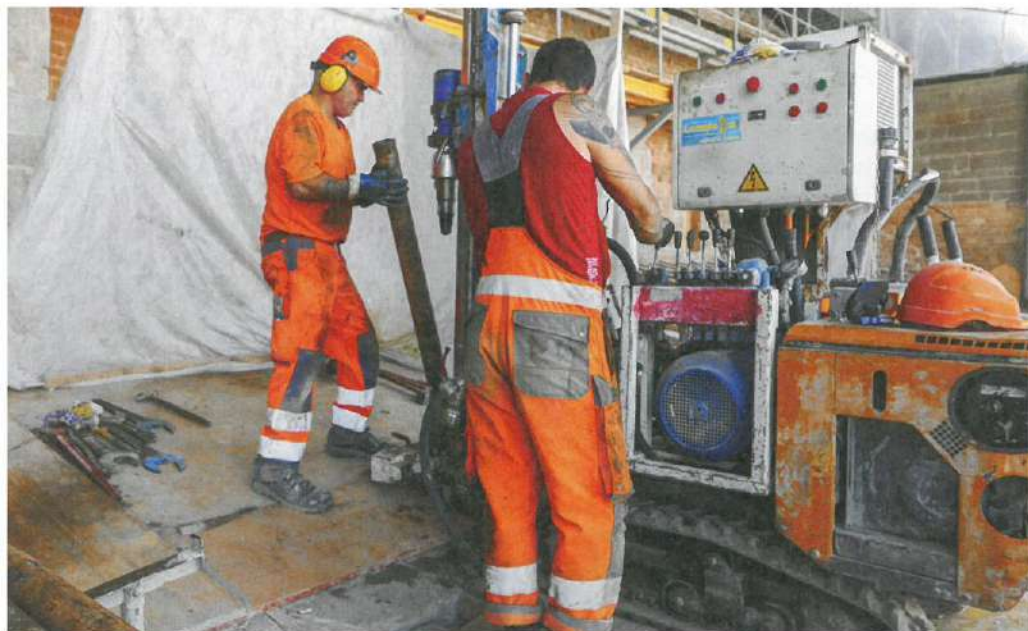
Forer à travers les piliers, puis dans un terrain moins dur, en maintenant un angle de 4 degrés requiert une précision incroyable et une attention de tous les instants.
