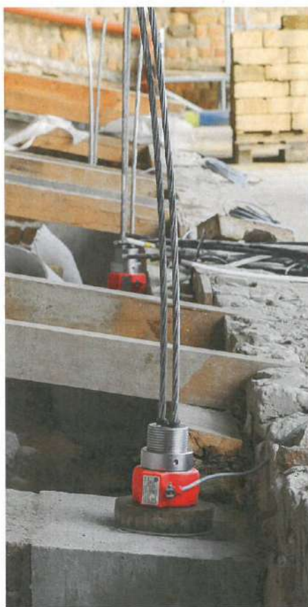
Neuf percements extrêmement précis ont été effectués depuis le sommet des murs. Les tirants longs de quelque 24 m, composés chacun de trois torons d'environ 20 mm de diamètre, exercent désormais un effet de pince sur l'édifice.
